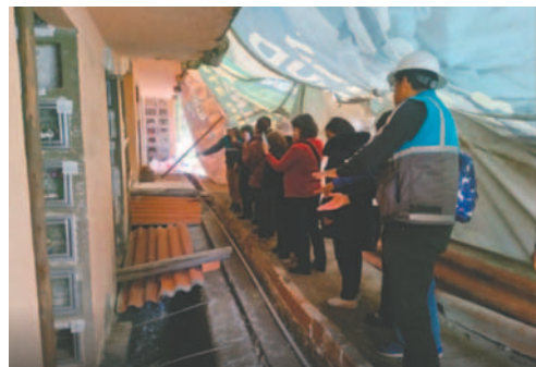
Trabajos que iniciaron ayer para el traslado de los ataúdes / AMUN
