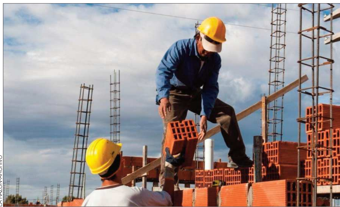
TRABAJO. El sector de la construcción es uno de los que aporta al crecimiento económico en Bolivia.
