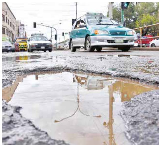
Un bache de magnitud en el centro de la ciudad. JOSÉ ROCHA
