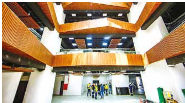
Las instalaciones del nuevo edificio municipal. H. ANDIA
