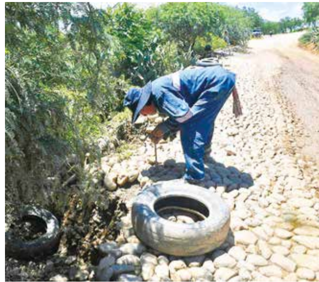
Los trabajos paliativos que se realizan en la zona.
