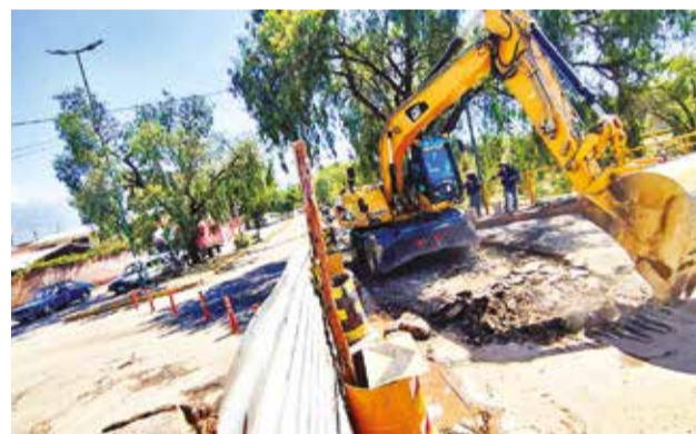
El cierre del puente Killman por obras del tren. D. JAMES
