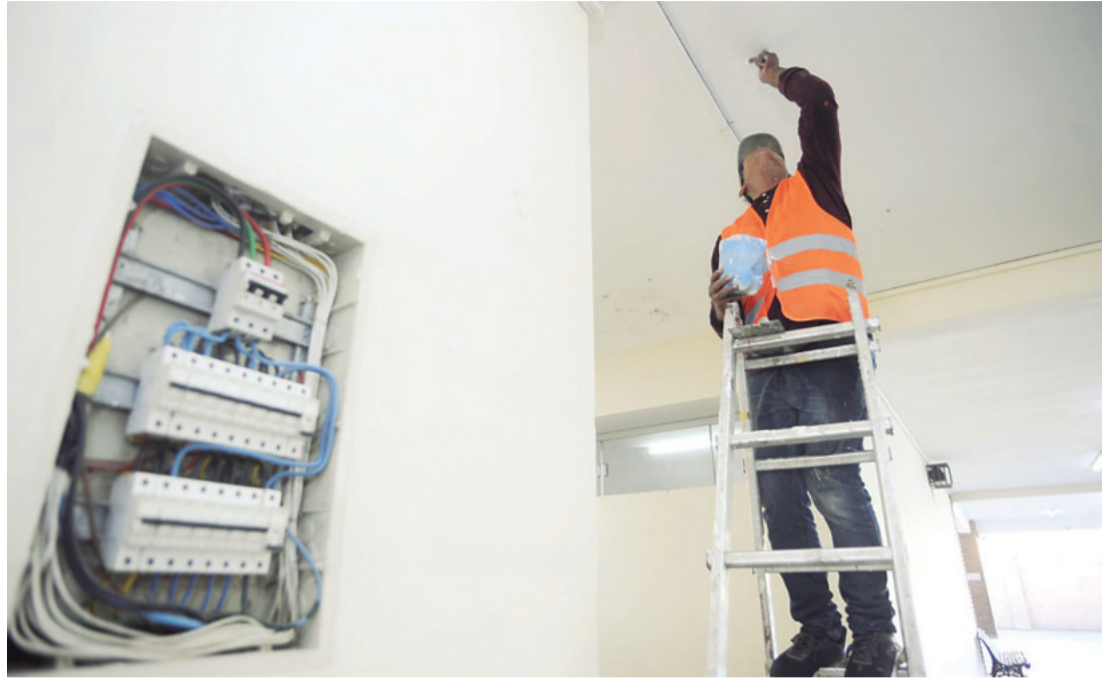
La Alcaldía inspeccionó los trabajos que se realizan en el colegio Mirette Sciaroni
