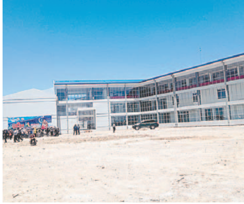
Vista general de la infraestructura de Puerto Seco /LA PATRIA
