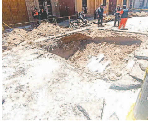
Empresa adjudicada realiza renovación del alcantarillado pluvial /GAMO
