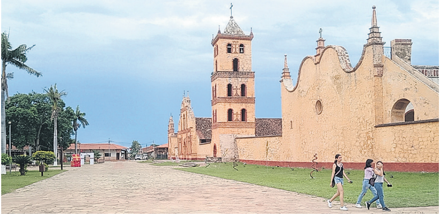
La Iglesia de San José de Chiquitos es la única de las misiones de Chiquitos que fue construida con piedras. La infraestructura es imponente.
