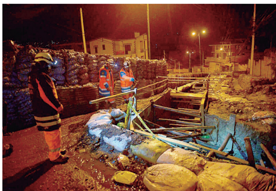
Los trabajos que se realizan en la zona de Bajo Llojeta, en la ciudad de La Paz
