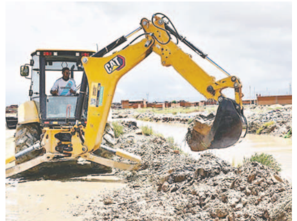
Sectores anegados por las lluvias son intervenidos con maquinaria /GAMO
