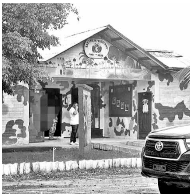
La fachada del cuartel donde ocurrió el hecho. CORTESÍA
