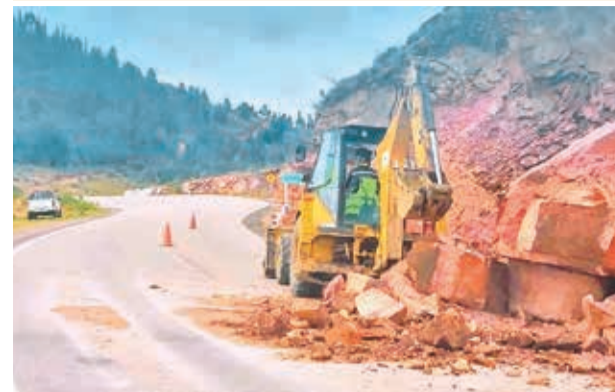
El mantenimiento de vías que se realiza. ABC
