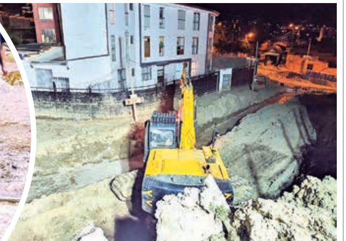
Instalación de defensivos en Bajo Llojeta. GAMLP
