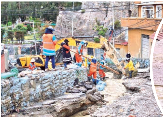
Trabajos en Bajo Llojeta. GAMLP
