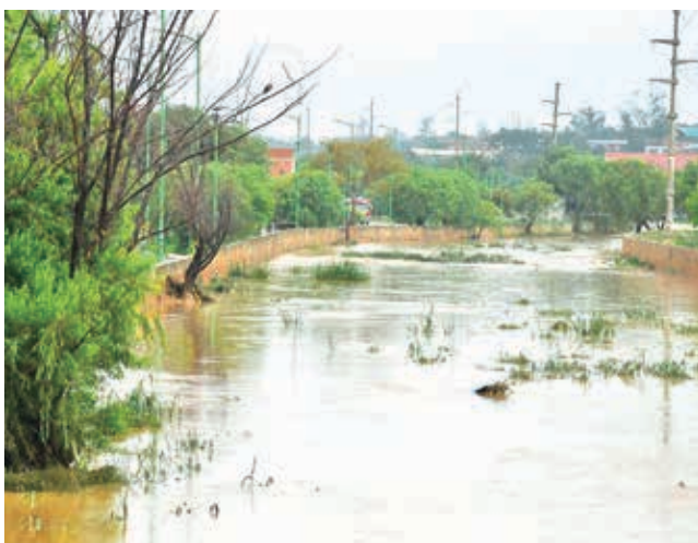
La crecida del nivel del río Tamborada, al sur.
