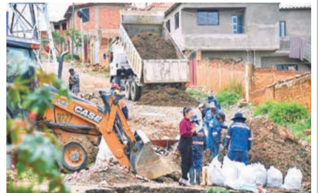
Una de las vías dañadas por los deslizamientos.
