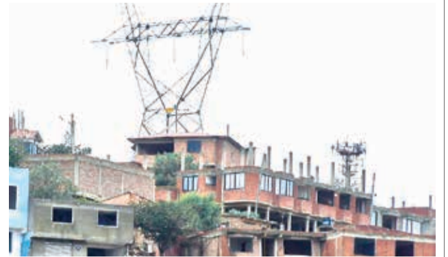
Las torres de transmisión eléctrica en la zona de riesgo.
