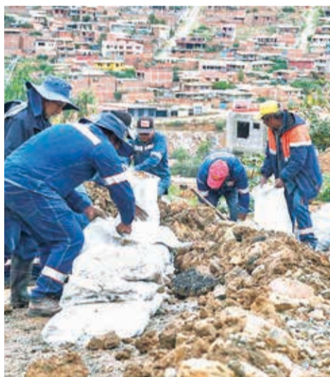
Los trabajos paliativos que realiza la UGR en la zona de alto riesgo.
