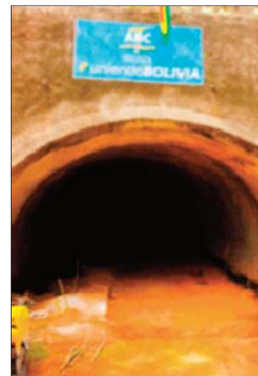
La construcción del túnel.
