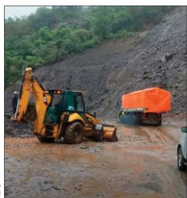
ABC realiza mantenimiento de vías.
