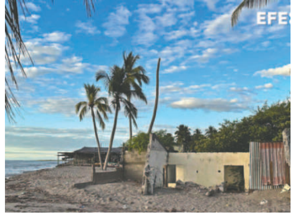
Viviendas destruidas en la costa de la comunidad de Cedeño /EFE
