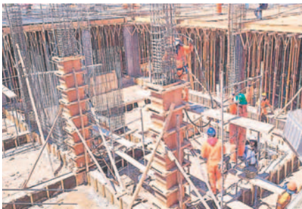
Hospital Isaías avanza en su ejecución física /GAM0
