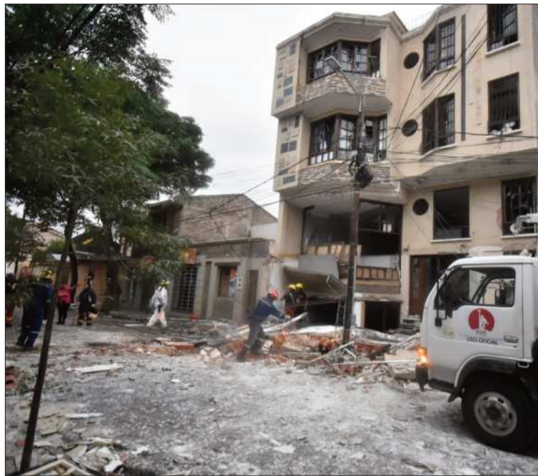
TARIJA. La explosión dejó seriamente dañado al edificio.
