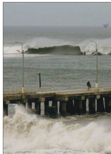
El oleaje provocó daños.
