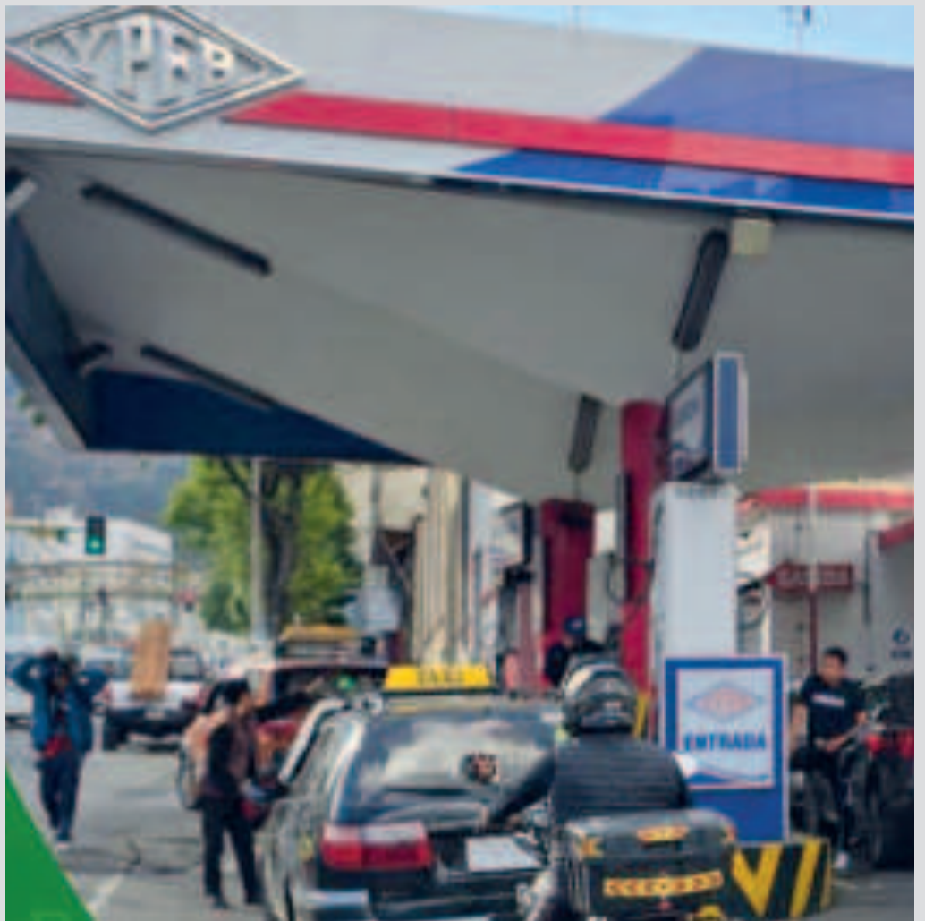
Estación de servicio de combustibles.
