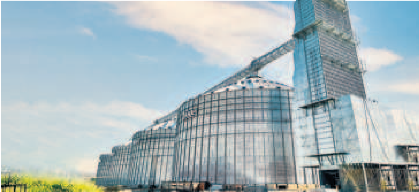
La Planta de Almacenamiento de Granos, en Pailón, Santa Cruz.
