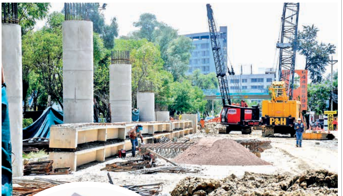
Las obras del distribuidor de la Perú y Blanco Galindo.
