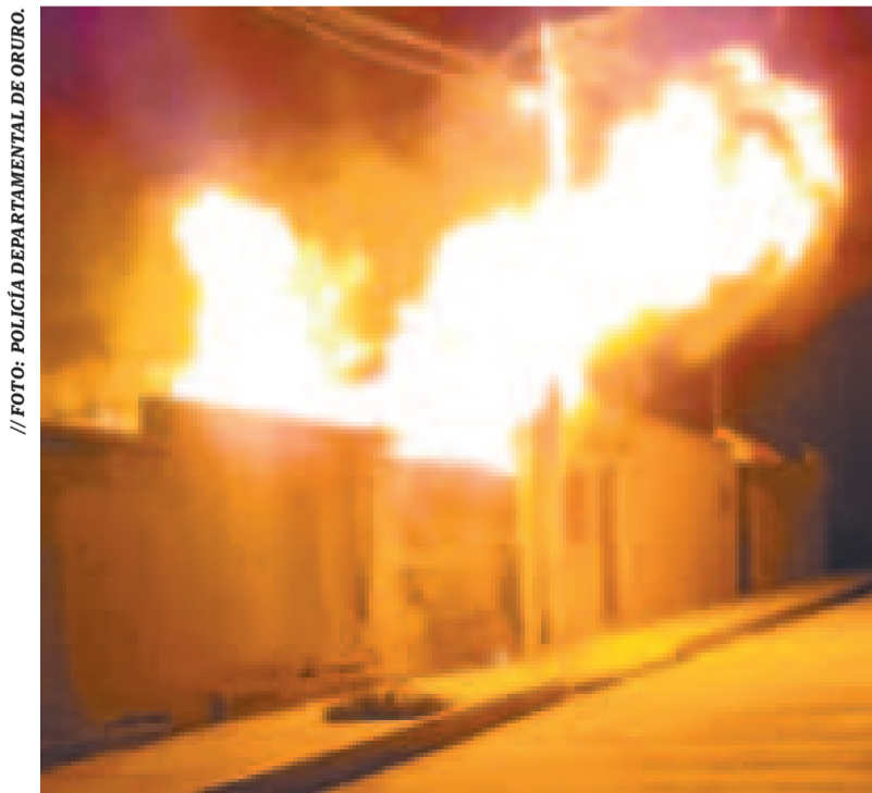
Incendio registrado en un taller de transformadores.
