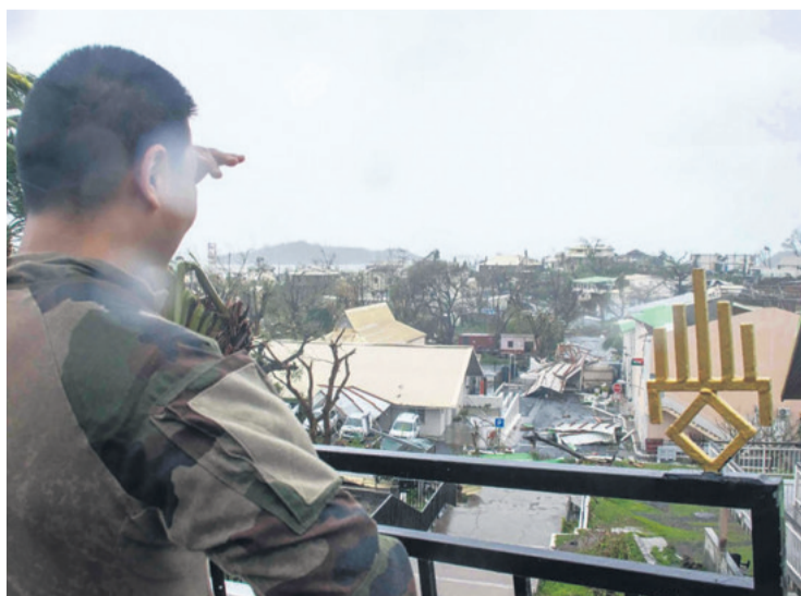
La destrucción causada por el ciclón Chido en la isla Mayotte
