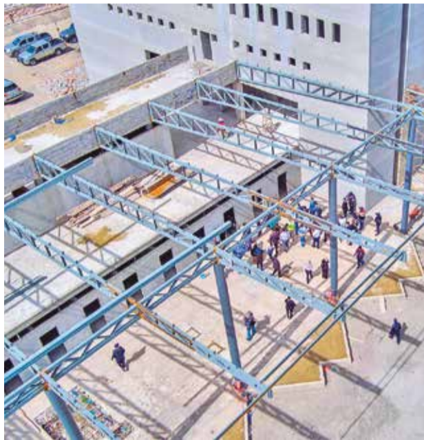
Los trabajos de la obra gruesa de la nueva terminal. GAMC
