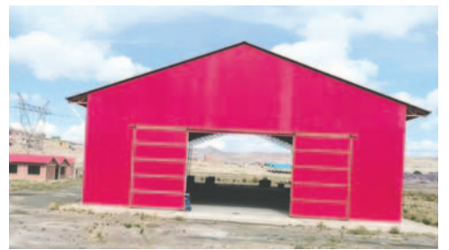
Imagen de la Planta de Compostaje /ARCHIVO
