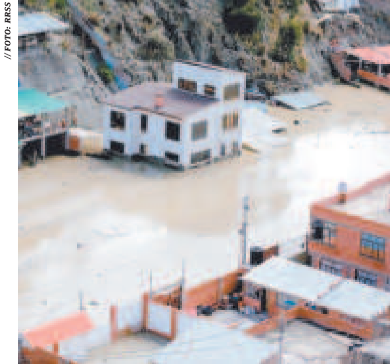
La mazamorra afectó a más de 40 viviendas en Bajo Llojeta.
