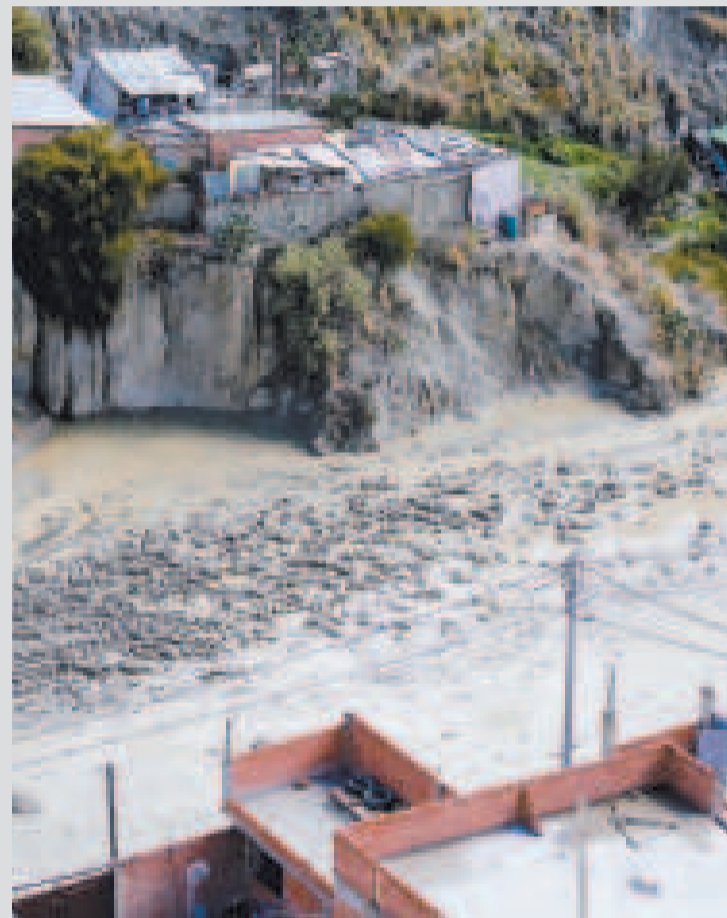
Bajo Llojeta afectada por un deslizamiento de tierras el fin de semana.
