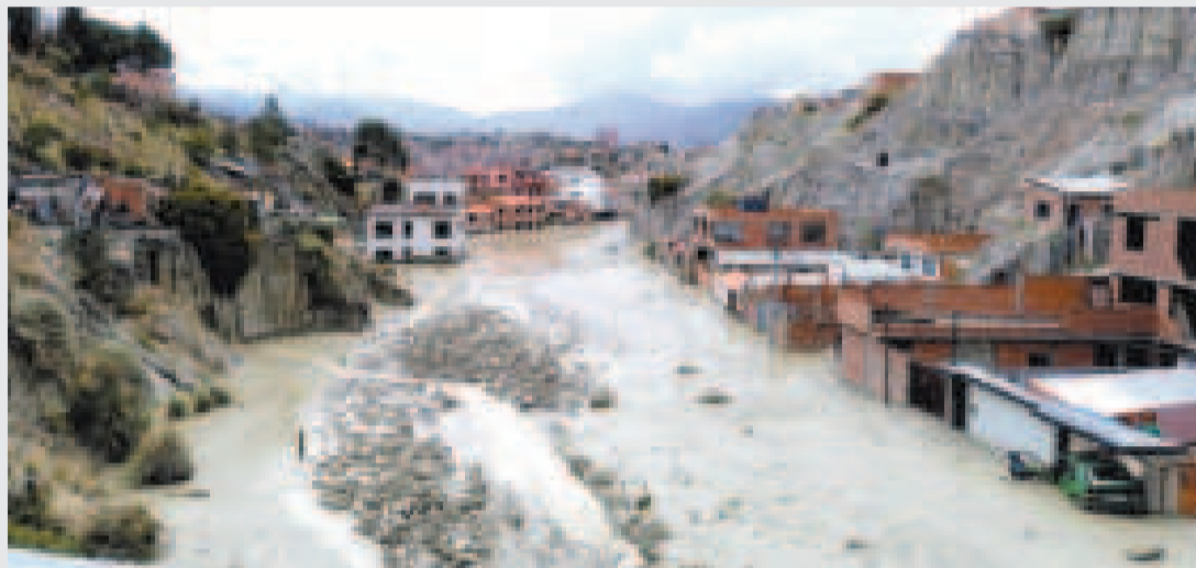
Casas en la zona de Bajo Llojeta afectadas por movimientos de tierra.
