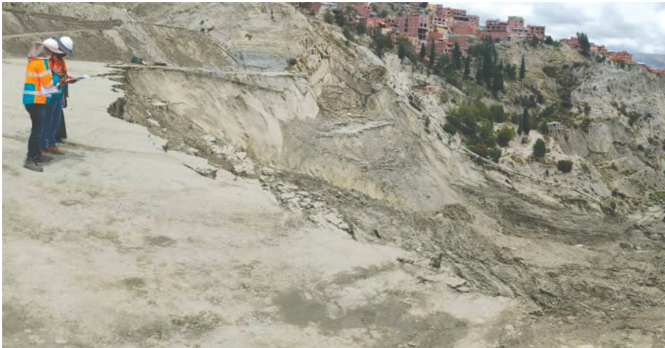
Una inspección en el predio tras el deslizamiento /GAMLP
