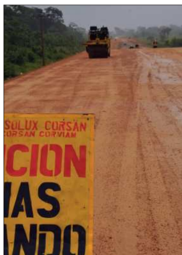
Construcción de una carretera.
