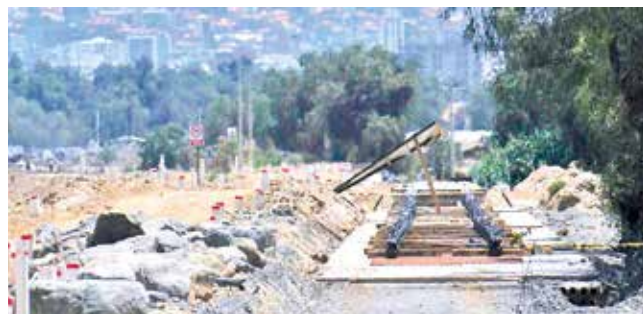
Los trabajos en la zona de Maica Chica, al sur.
