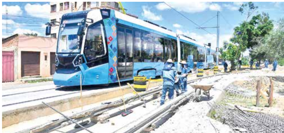
Los trabajos de desvío por las obras de la línea amarilla del tren ayer. FOTOS: CARLOS LÓPEZ
