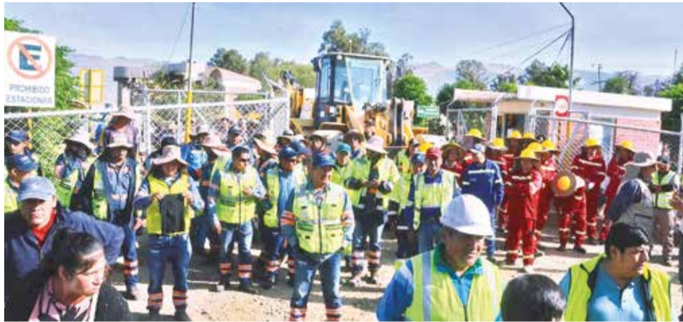
El acto del inicio de las obras del emisario sudeste ayer. FOTOS: HERNÁN ANDÍA
