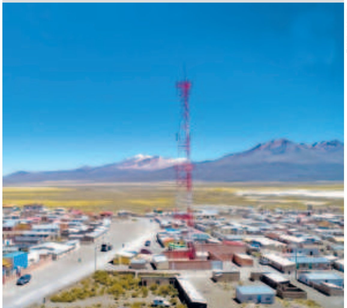
Una estación radiobase instalada por la estatal Entel.
