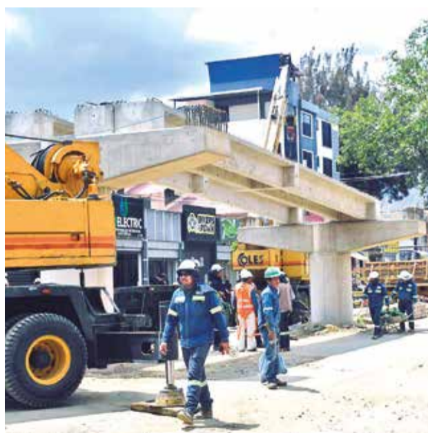
Los trabajos del distribuidor de la Perú ayer. CARLOS LÓPEZ
