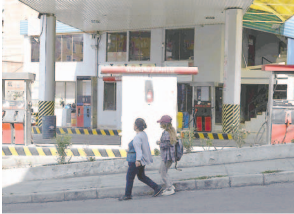
Surtidores otra vez se cerraron por la falta de llegada del producto /EFE
