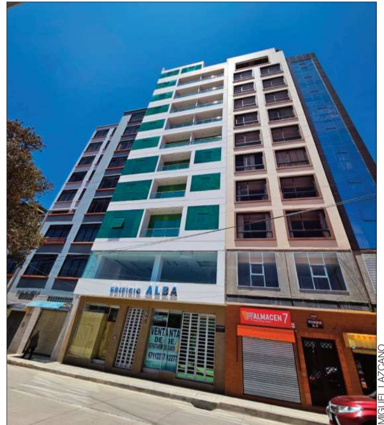
EDIFICACIONES. En El Alto existe un boom de construcciones.
