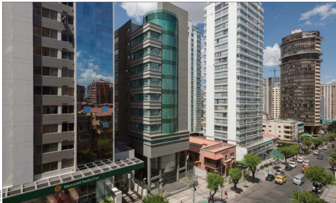
FENÓMENO. En el eje troncal hay una tendencia de construcción vertical.
