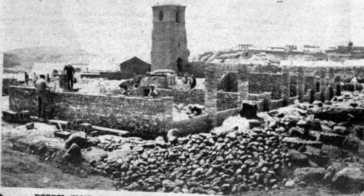
POTOSI, (HOY).— Parte de los trabajos realizados de la escuela que actualmente se construye en la Villa Imperial. La obra será concluida a mediados de este año. El edificio se levanta sobre una superficie de 2.000 metros cuadrados.
