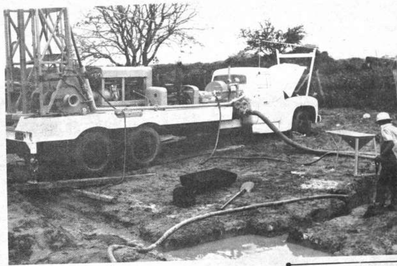
SANTA CRUZ, (HOY).— Personal y maquinaria dependiente del Comité de Obras Públicas trabaja actualmente con normalidad en la apertura de pozos para dotar de agua a las zonas suburbanas de la ciudad. La foto fue tomada cuando se realizaba esta tarea en la zona de "El Trompillo".
