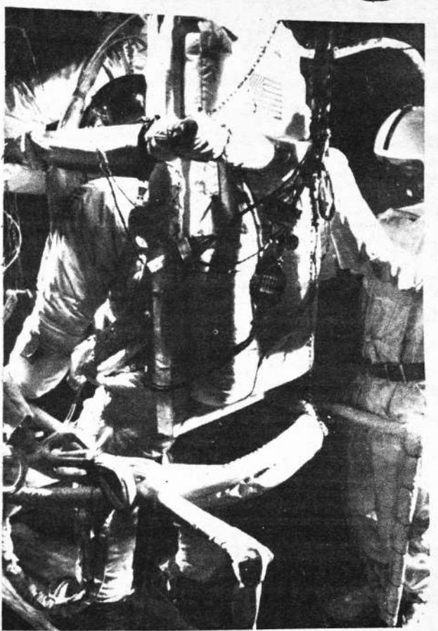
DOS TECNICOS ensayan el equipo de maniobras extravehiculares que el astronauta se coloca en la espalda y le suministran los medios de sobrevivir en el espacio, en un cuarto donde se simulan las condiciones espaciales y donde se mantienen una sexta parte de la gravedad de la tierra, que es la que reina en la luna.
