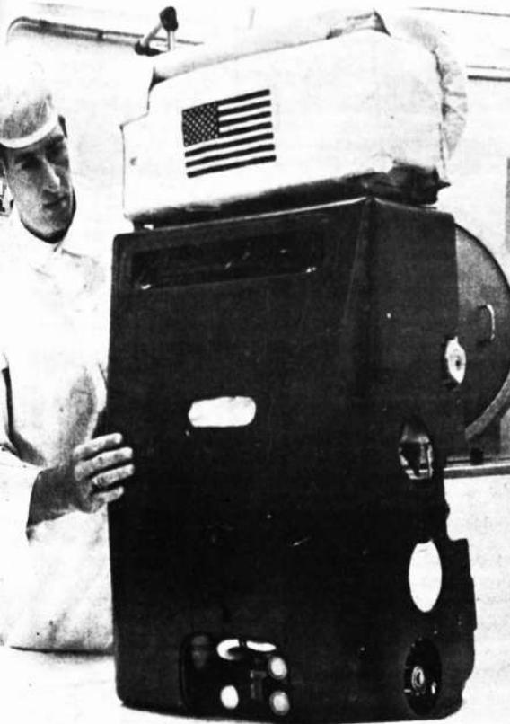
EQUIPO.— Un técnico examina el equipo de maniobras extravehiculares que se colocará a la espalda del astronauta Schweikart cuando lleve a cabo su caminata espacial durante la misión de la nave Apolo 9, en vuelo en órbita alrededor de la tierra.
