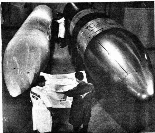
POSEIDON — La producción del proyectil balístico de la Marina de los EE. UU., Poseidón (derecha) se inició en la planta de Lockheed, en Sunnyvale, California. A la izquierda está el Polaris A3 que será reemplazado. Poseidón está diseñado para llevar doble carga que su predecesor y será armado con múltiple y detonadores separados para darle mayor efectividad contra las defensas enemigas.
