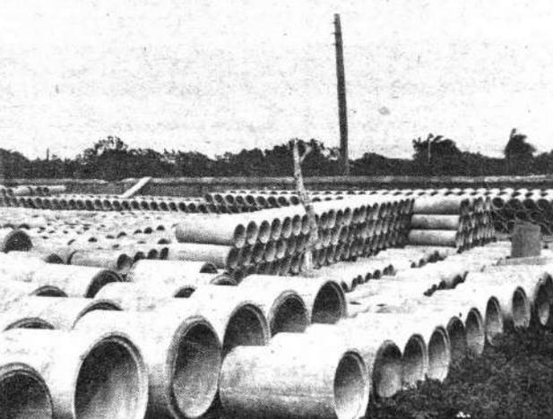
ALCANTARILLADO.— Otra de las obras encaradas en Santa Cruz, es la dotación del alcantarillado. En la nota se puede ver la tubería lista para ser colocada.
