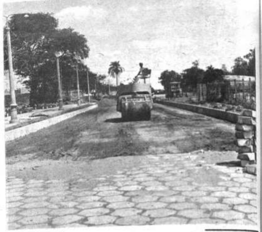
SANTA CRUZ.— La colocación de losas en la ciudad alcanza a 300 cuadras, según el Comité de Obras Públicas. Los trabajos se aceleran en esta nueva etapa, esperándose que culminarán en 1970.
