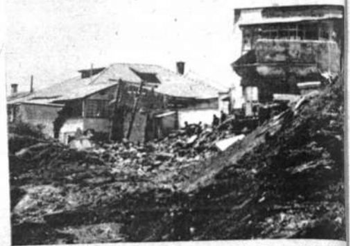
Las pérdidas por derrumbes que ocasionaron las últimas lluvias pueden aumentar los próximos días, debido a que varias casas están en peligro inminente de desmoronarse.
