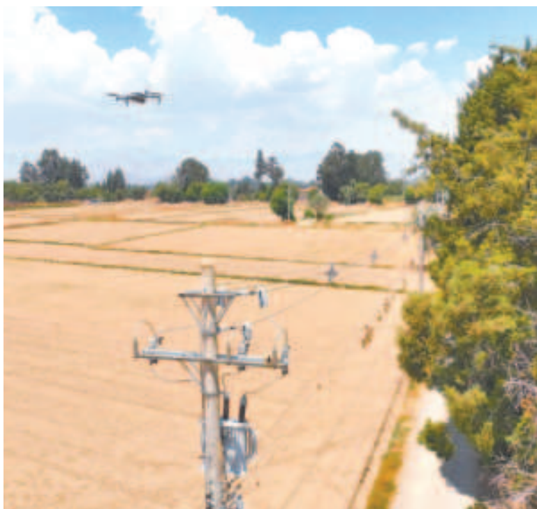
Un dron termográfico en la inspección de una red eléctrica.
