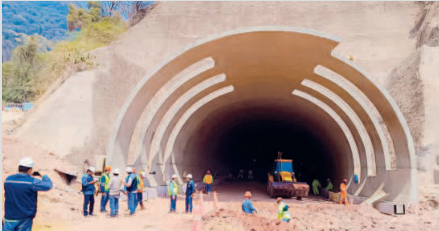
Inspección del túnel de Incahuasi por parte de autoridades de la Administradora Boliviana de Carreteras.
