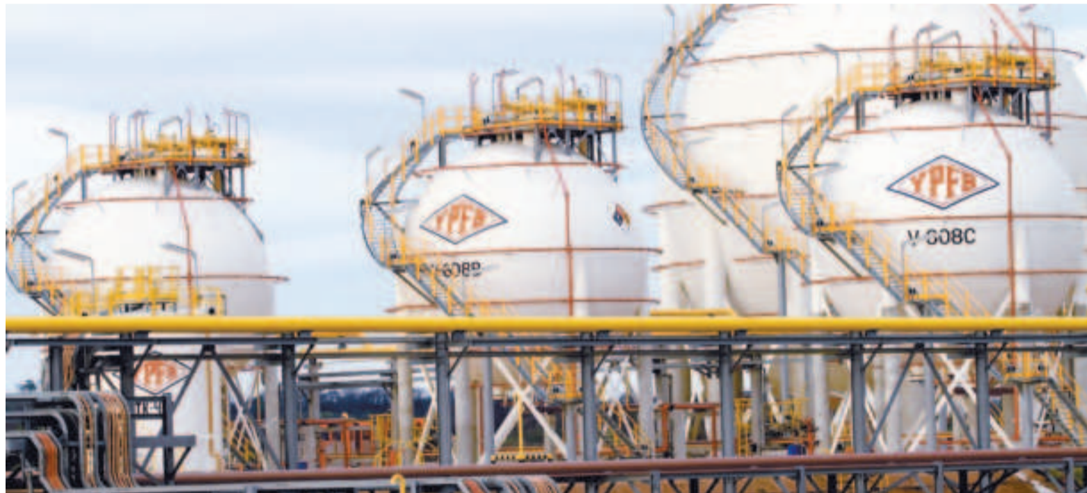
Parte de la infraestructura de la planta de Gran Chaco.
