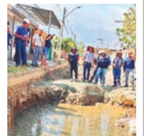
Autoridades verifican avance de la obra. ALD
