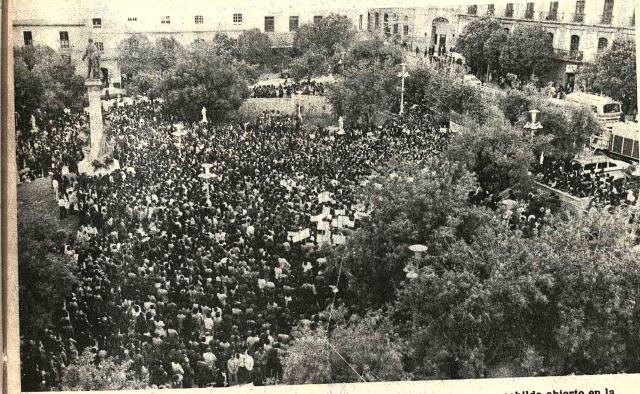
CABILDO ABIERTO.- Las instituciones cívicas de La Paz efectuaron ayer un cabildo abierto en la Plaza Machado y, en su transcurso, insistieron en la necesidad de poner en marcha de inmediato las obras de instalación del ingenio azucarero de San Buenaventura. En la concentración, se aprobó un documento de seis puntos, uno de los cuales declara en estado de emergencia a las instituciones cívicas y amenaza con ir a la huelga, a partir del 28 de febrero no se toman medidas concretas, sobre el proyecto.
