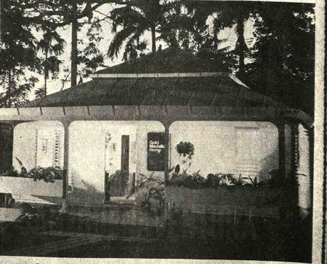
Casa de bajo costo construida con madera prensada, derivada de la cáscara de la caña de azúcar, debidamente tratada contra incendios, contra el deterioro por insectos y para darle gran resistencia.
