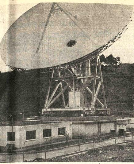
**ESTACION TERRENA.** Uno de los logros efectivos realizados en 1979, fue la instalación de la estación terrena "Tobouacra", cuya antena parabólica de comunicaciones por satélite fue instalada por ENTEL. El avanzado sistema electrónico de seguimiento, permite moverla cada vez que sea necesario para seguir la trayectoria del satélite "Intelsat IV-A" ubicado en órbita fija en el espacio.
