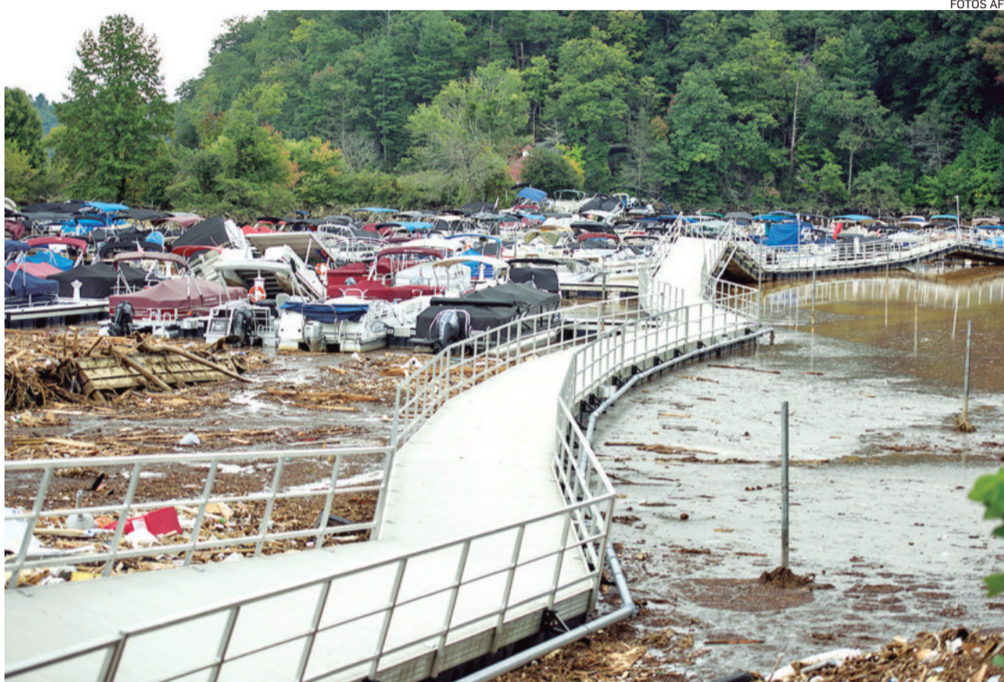
Una vista de los daños causados por la tormenta tras el huracán Helene en Valdosta, Georgia
