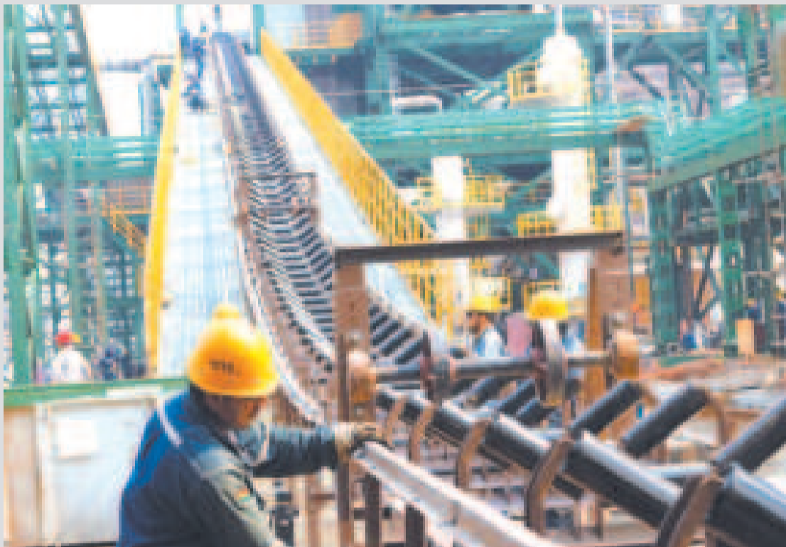
Los trabajos de instalación de equipos en el complejo del Mutún.
